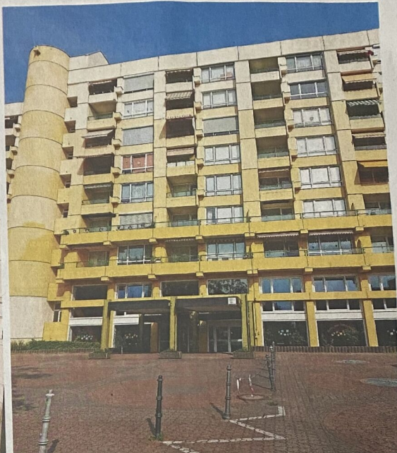
Die Einrichtung im Amselweg 23 fällt durch ihre markante gelbe Fassade schon aus der Entfernung gut auf.
