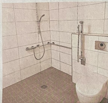
Die Bäder sind alle modernisiert und verfügen über bodenebene Duschen, die barrierefrei erreichbar sind.
